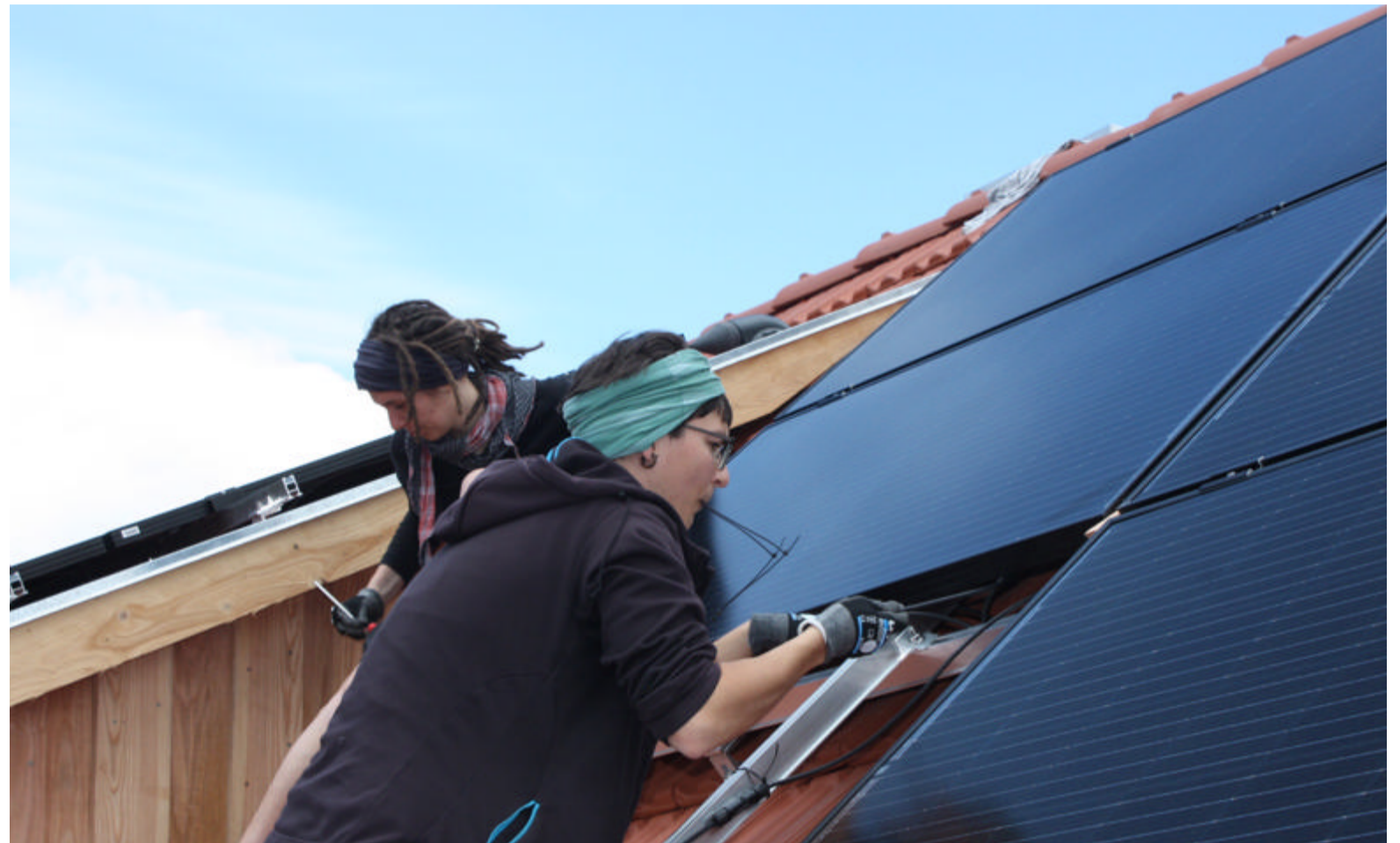
▲ Kerstin und Lea von SoLocal Energy Kassel beim Verkabeln von Photovoltaik-Modulen.
